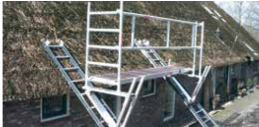
Daksteiger Echafaudage toiture RDS
