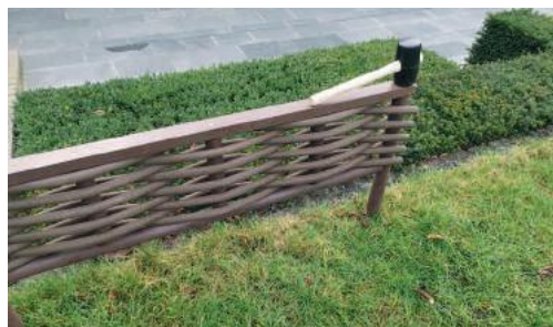
Foto : installatie van ecowood border
