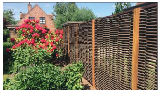
installatie met ondersteuningsprofiel
