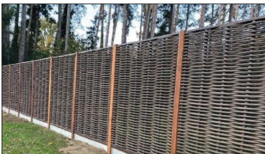
installatie met betonplaat
