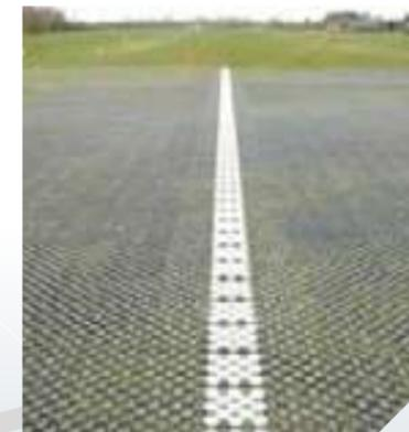
Positionner les plots de marquage avant de compacter. Tasser les dalles avec un rouleau compresseur afin de les enfoncer dans la surface engazonnée.
