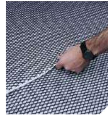
1A - En toiture, un géo-espaisseur est positionné entre l'étanchéité et les dalles afin d'assurer le drainage horizontal des eaux de pluies.
