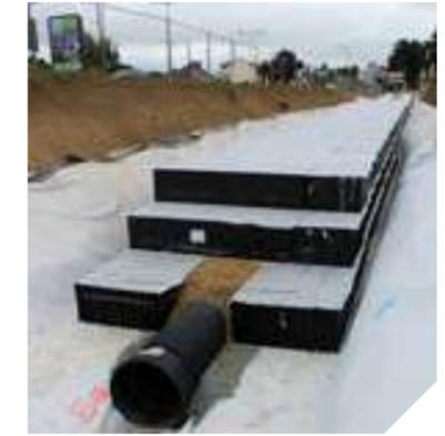
Le terrassement englobe l'emprise du bassin et une zone d'accès sécurisée d'au moins 0,50 m en périphérie de l'ouvrage. Un géotextile de 300 g/m<sup>2</sup> ou un complexe d'étanchéité est mis en place afin de créer l'enveloppe du bassin. Ils sont disposés sur le lit de pose et remontés sur les faces latérales de l'ouvrage. Ils seront mis en place sur la face supérieure des modules à la fin de leur installation.
