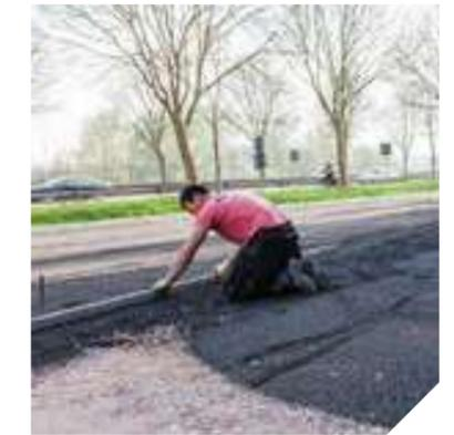
Prévoir un terrassement en fonction de l'application finale puis poser un géotextile avant la couche de fondation. Recouvrir la couche de fondation d'une couche de nivellement et bien compacter l'ensemble. Poser ensuite les bordures en prévoyant un dépassement de 1 à 2 cm au-dessus du niveau final des graviers.
