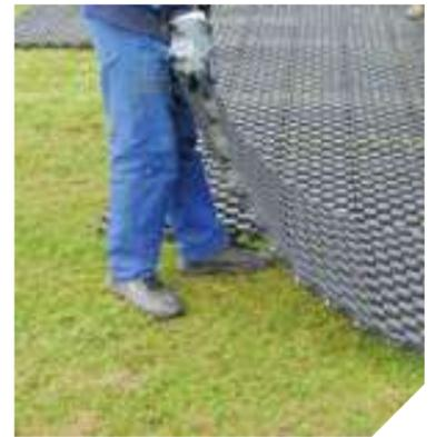
**1A** - Si le terrain enherbé est déjà plat et drainant, il suffit de tondre l'herbe aussi court que possible, vérifier la capacité portante du sol support et niveler les petites ondulations du terrain en utilisant une couche arable ou un mélange de sable et de terre.
