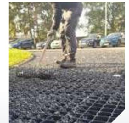
Commencer la pose des dalles à une extrémité du chantier en positionnant les systèmes de fixation dans le sens d'avancement.
