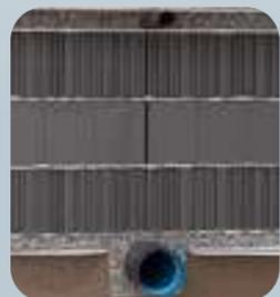
Passage du drain dans une tranchée drainante sous les blocs.
