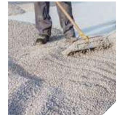
Poser les plaques nida gravel bord à bord à joints croisés. Disposer le géotextile qui dépasse des deux côtés sous la plaque voisine. Un ancrage mécanique n'est pas nécessaire. Remplir les plaques de graviers et les recouvrir d'une épaisseur de 1 à 2 cm. Nivelier et compacter si nécessaire.
