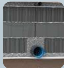
Passage du drain entre les blocs avec un lit de diffusion sous les blocs.
