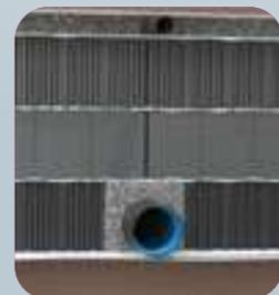
Passage du drain entre les blocs avec utilisation des blocs Nidaflow.
