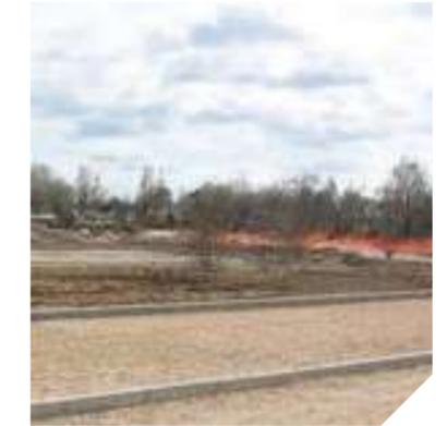
Décaisser le sol. En fonction de la nature du fond de forme et une fois sa portance mesurée, réaliser la couche de fondation drainante.
